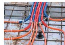
Прямо под сеткой укладываются трубы системы отопления, то есть обустроить контур «теплых полов». Прокладка коммуникаций
