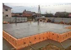
На этом же этапе собирается опалубка, которая изнутри выкладывается тем же утеплителем. После
