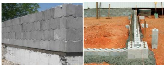
Высокая несущая способность обеспечивается конструктивной несущей частью блока толщиной 247мм и 2х-пустотной формой, имеющей специальный паз d=110мм. для армирования. С помощью пустот производится усиленное вертикальное армирование при многоэтажном домостроении с укладкой железобетонных плит перекрытия.
