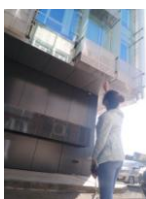
Реконструкция фасада по ул. Красной 4
