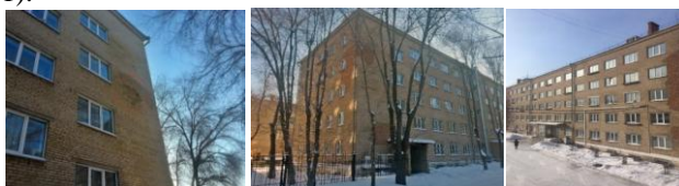
Рис 1. Разрушения кирпичной кладки
