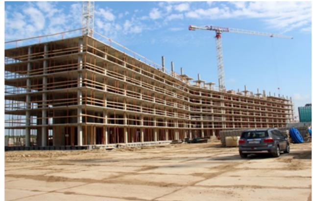
Рисунок 2. Сборно-монолитный безригельный каркас системы КУБ-3V
