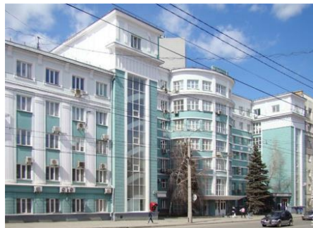
Административное здание, 1934г. ул. Воровского, 2. Арх. И. Ипполитов
