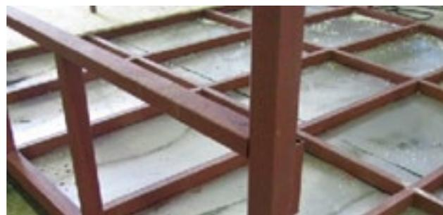
Рисунок 2. Каркас как основа для модульного здания
