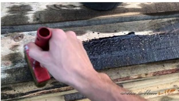
Рисунок 4. Обработка бруса отработанным маслом
