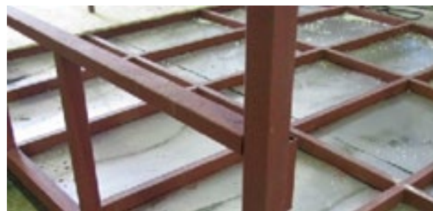
Рисунок 2. Каркас как основа для модульного здания
