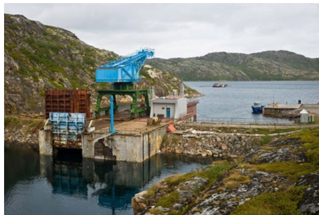
Рисунок 4. Плотина Кислогубской приливной электростанции. Кран периодически открывает и закрывает створ плотины
