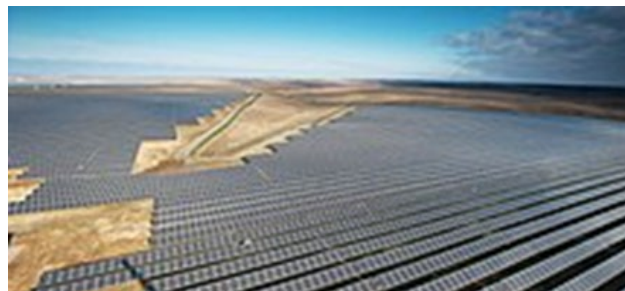
Рисунок 1. Самая мощная СЭС России Перово - мощность 105 МВт, состоит из 440 000 модулей установленных на более 200 гектарах площади (примерно 259 футбольных полей). Фото взято с сайта в Википедии «Список солнечных электростанций России»
