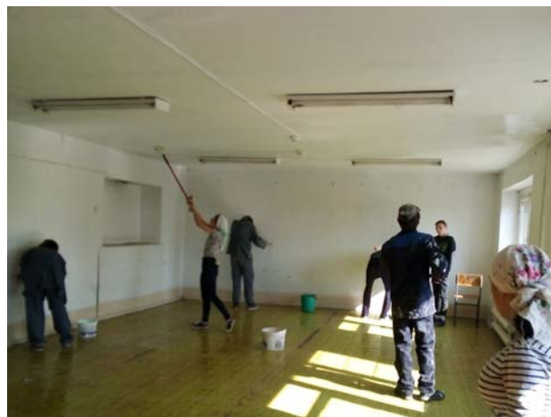
Рисунок 1. Подготовка помещения к отделочным работам
