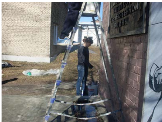
Рисунок 3. Внешние отделочные работы
