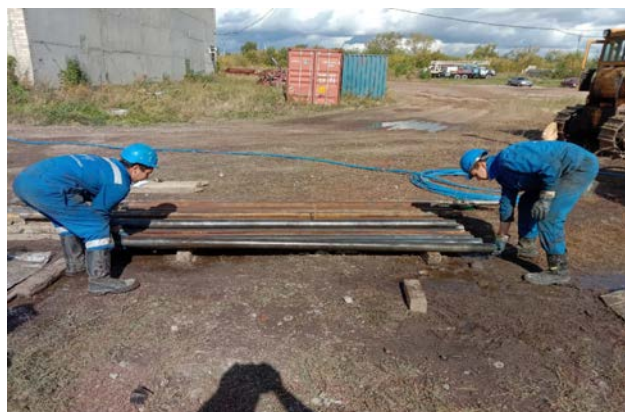
Рисунок 7. Сборка бурильной колонны
