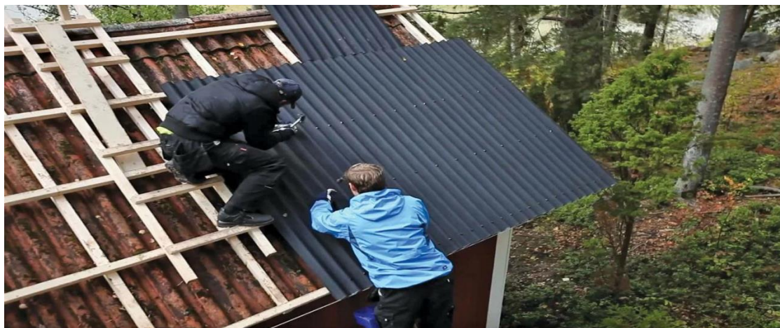
Рисунок 3 - Монтаж кровельного покрытия «Ондулин»
