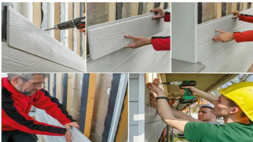
Рисунок 2 – Монтаж фиброцементных фасадных панелей марки «Бетэко Вудстоун БВС»
